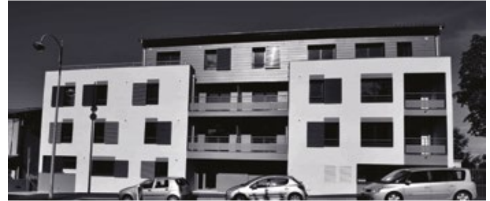
Exemple de réalisation de logements adaptés à Limonest (69), ville amie des aînés depuis 2010.
